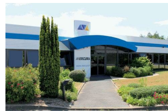
Standby Mercura in Blois u. Nantes, Frankreich
