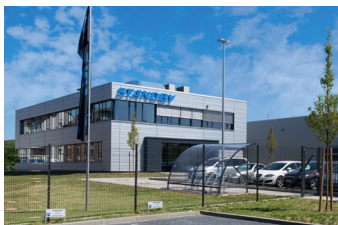
Standby GmbH in Dinslaken, Deutschland
